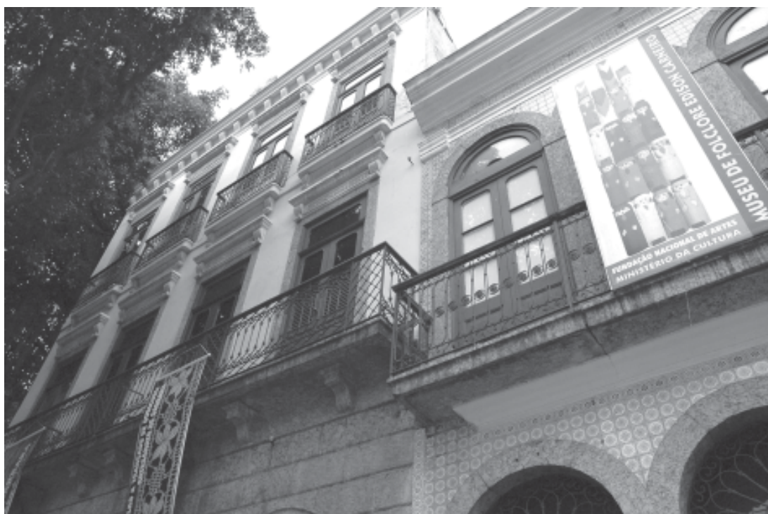
Fachada do Museu do Folclore Edison Carneiro
