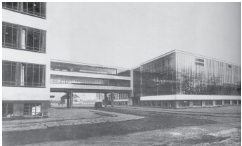
Modernismo. Walter Gropius, edifício Bauhaus, em Dessávia. Foto do livro Arquitetura no século XX , de Peter Gössel, Köln, 1996, p. 146.
